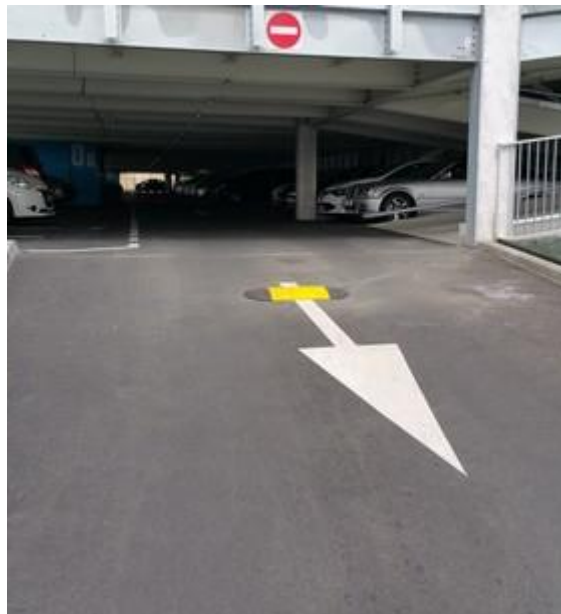
Exemple de ralentisseur équipé de détecteur magnétique en situation (Centrale Nucléaire de Saint Laurent des Eaux)
